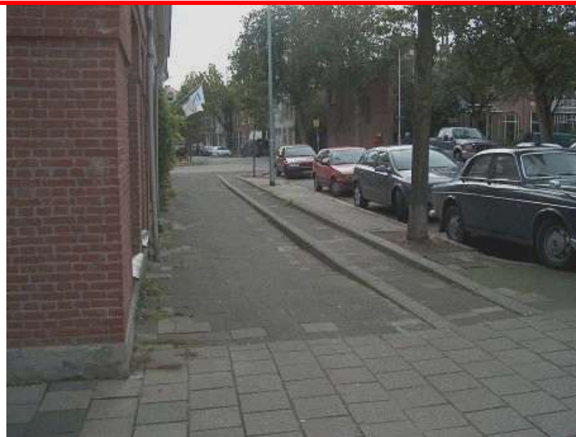
Figuur 06 Woningen op staal die zover zijn gezakt dat het trottoir verlaagd moest worden. Over een aantal jaren zijn nog grotere problemen te verwachten omdat de verzakking door blijft gaan. Op een gegeven moment zijn maatregelen in de openbare ruimte niet meer mogelijk. Let bij koop er op, dat de begane grondvloer nog voldoende hoog boven het trottoirniveau of de tuin ligt. In dit soort situaties extra letten op water in de kruipruimte, optrekkend vocht en mogelijk rotte balken onder de begane grondvloer.
