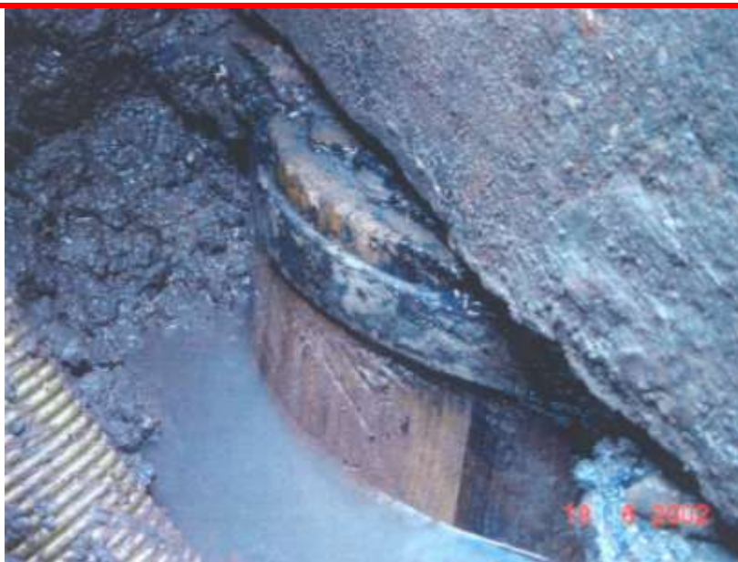
Figuur 22 Fundering aangetroffen in de Cronjestraat in Dordrecht (Foto Fugro) Hierbij zijn meerdere korte houten paaltjes in een ton als fundering gebruikt. Mogelijk als funderingsverbetering. Als deze paaltjes niet de lengte hebben tot aan de dragende zandlaag scharen we deze onder staalfunderingen.
