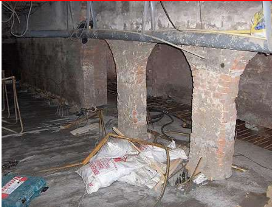
Figuur 20 Spaarbogen bij een fundering waar funderingsherstel wordt uitgevoerd (Rozenhof Dordrecht)
