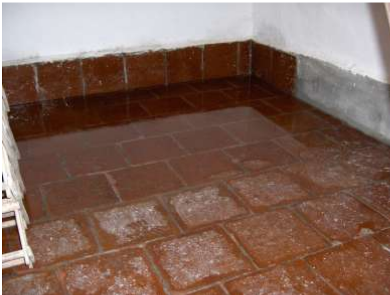
lekke kelder na funderingsherstel
