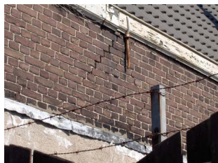
Scheurvorming
