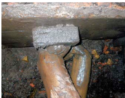
Slecht (links) en goed functionerende fundering.
