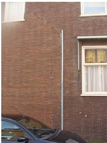
Figuur 15 Scheurvorming
