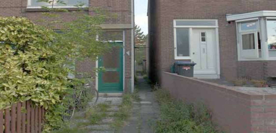
Links fundering op staal en rechts op houten palen
