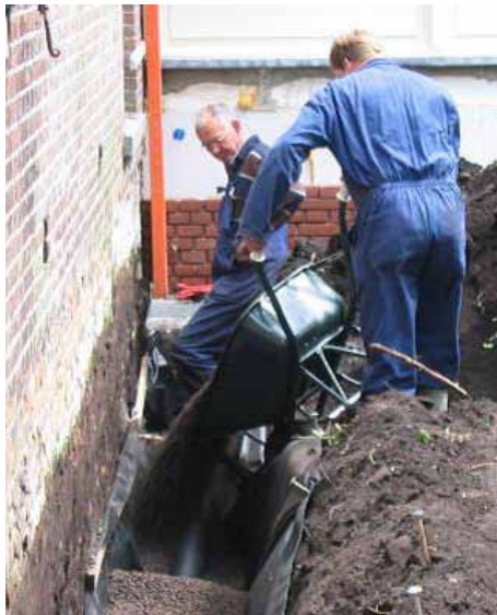
Aanleg infiltratieleiding langs gevel
