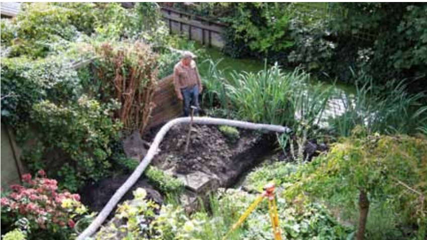
Aanleg infiltratieleiding aangesloten op het oppervlaktewater in Oud-Hillegersberg te Rotterdam
