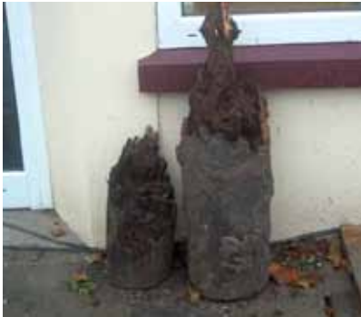
Funderingspalen na langdurige droogstand, draagvermogen 0%.
