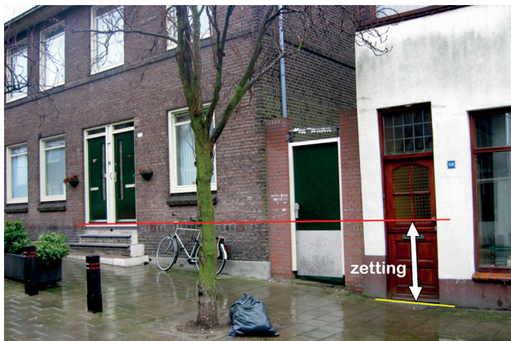
Foto: Combinatie van panden met fundering op staal en op houten palen.
