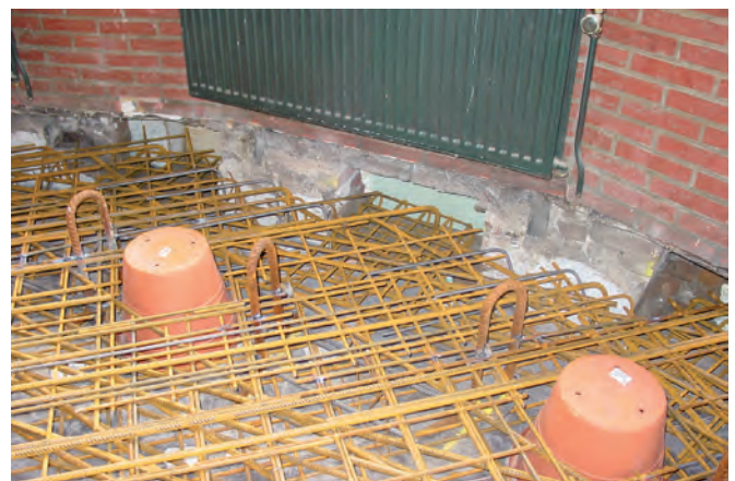
Figuur 5-2a,b,c Voorbeelden methode 1 - betonvloer met inkassing in metselwerk en springen.
