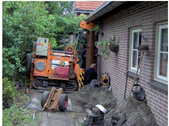
Figuur 5-1 Inwendig heien van stalen buispalen.
