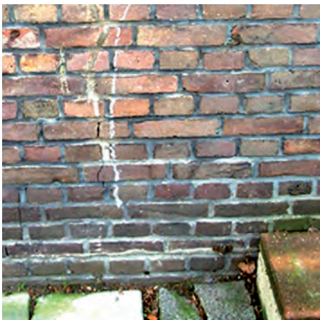
Figuur 4-7 Zeer plaatselijke scheurvorming direct boven fundering.
