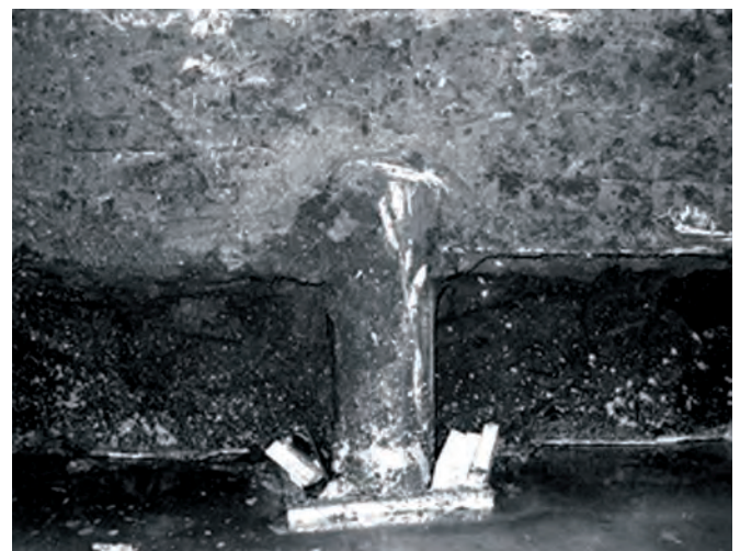
Figuur B-2 Voorbeeld van doorponsen langshout en metselwerk als gevolg van overschrijden maximaal opneembare drukspanning F_{d,paal} = 140 \text{ kN} ; paalkop \varnothing 250 \text{ mm} ; \sigma_d \approx 2,9 \text{ N/mm}^2 [bron: funderingsherstel te Rotterdam]
