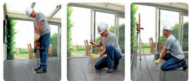
Figuur 6-5 Boren, injectiepijp plaatsen en injecteren.
