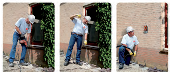
Figuur 6-1 Boren, injectielans plaatsen en injecteren.
