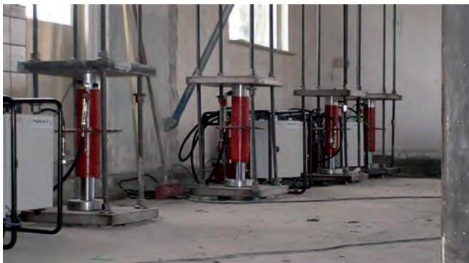
Figuur 5-7 Voorbeeld opvijzelen gebouw.
