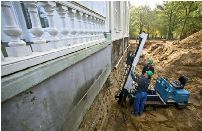
Figuur 6-4 Aanbrengen injectielansen met boorstelling.
