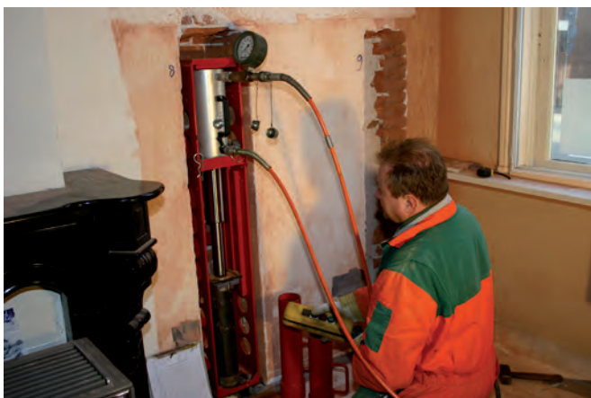
Figuur 5-9 Wegdrücken paal vanuit kas in de bouwmuur met persframe.
