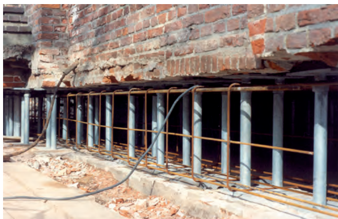
Figuur 6-7 Versterken fundering op staal met gewapend betonbalk.
