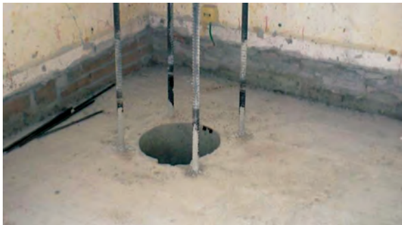
Figuur 5-5 Betonvloer met sparing en trekwapening (voorbeeld).
