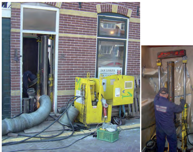
Figuur 5-3a,b Voorbeeld inpersen stalen buispaal met perscilinders/vijzel.
