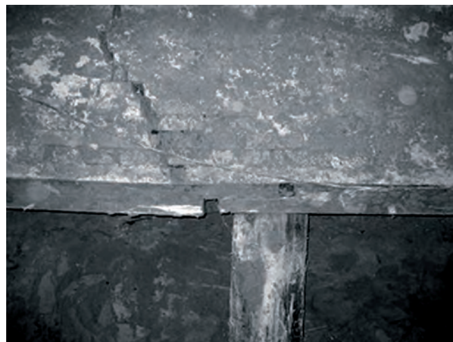
Figuur 4-5 Verschuiving langshout ter plaatse van scheur in metselwerk.
