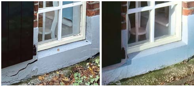
Figuur 7 – Scheur in een dorpel van het museum ontstaan in de zomer (links) en weer vrijwel dichtgetrokken in de winter (rechts), in de grafiek met de cumulatieve hoeveelheid regen.
