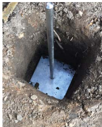
Figuur 7c – De 0,6 m zakbaken zijn geplaatst door een gat te graven tot een diepte waarbij de (harde geel-kleurige) klei-leemlaag zichtbaar is.
