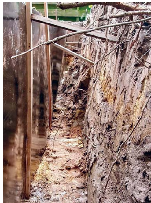
Figuur 16 – Sleuf voor het aanbrengen van de verticale barrière, bovenin zijn de doorgesneden wortels te zien.
