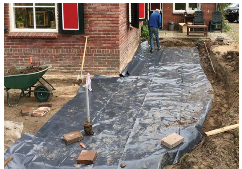
Figuur 4 – Aanbrengen horizontale vochtbarrière.
