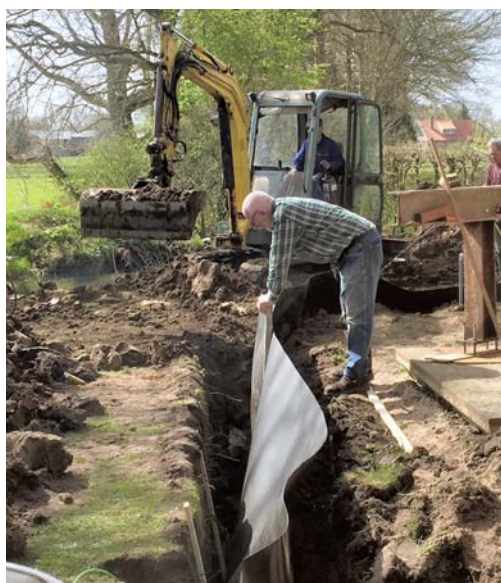
Figuur 3 – Aanbrengen verticale vochtbarrière.
