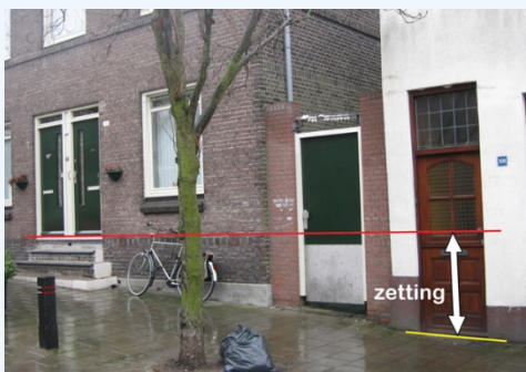
Figuur 2: Grens tussen blok op palen en blok op staal met bodemdaling
