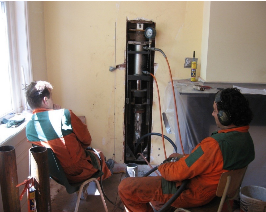
Figuur 11 Van uit sparing in de muur gedrukte funderingspalen
