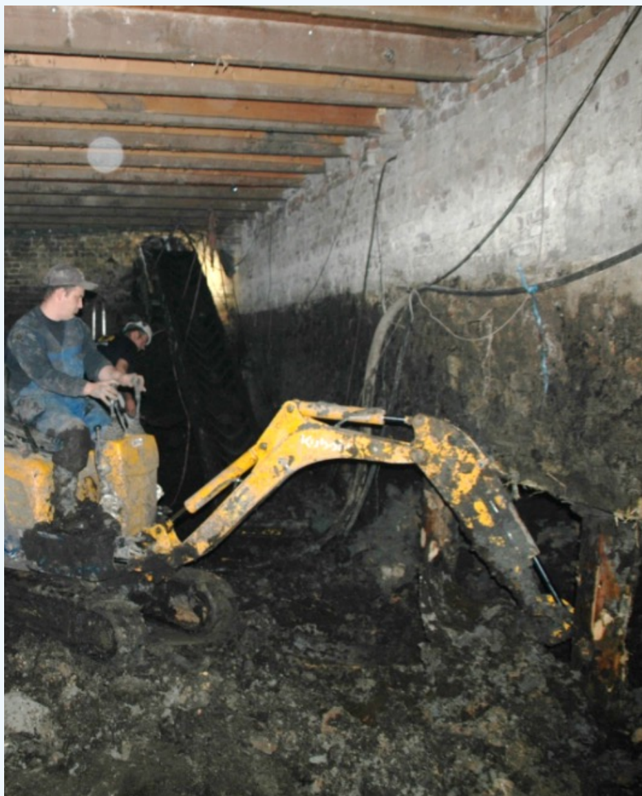
Figuur 9 Ontgraving ten behoeve van funderingsherstel
