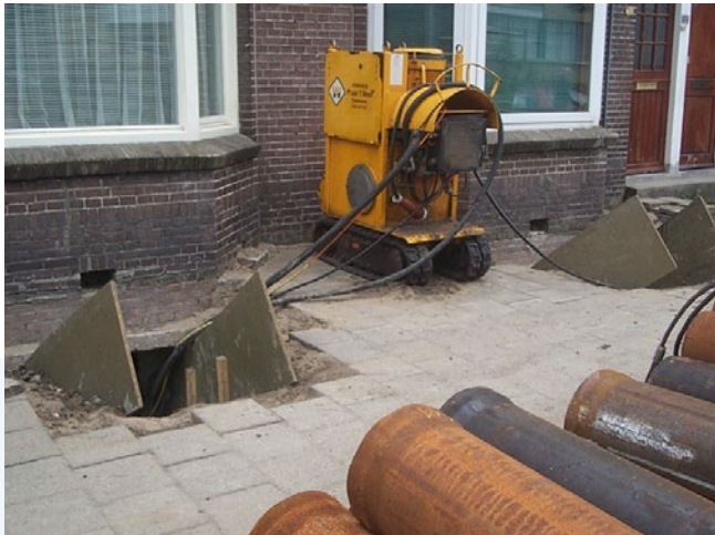
Figuur 12 en 13 Een nieuwe fundering met stalen buispalen
