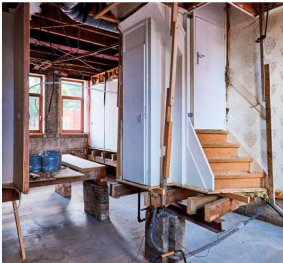
Figuur 14 Funderingsherstel bovengronds begane grondvloer verwijderd
