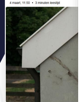
Een scheur als gevolg van verzakking. © Omroep Gelderland
